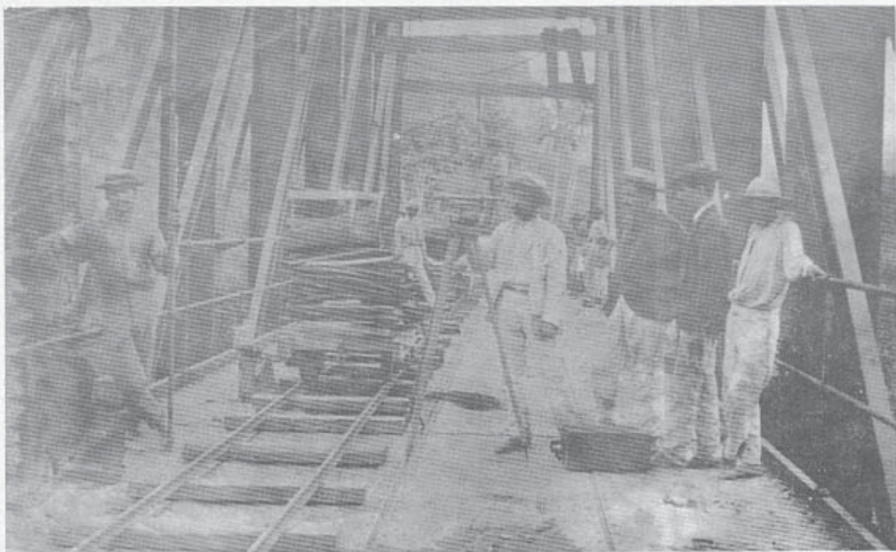
Construcción del Puente "Mata de Platano" en el 1914. En la foto Juan J. Jiménez ingeniero contratista del proyecto. El puente se conoce hoy día como Juan J. Jiménez. FOTO CORTESIA DE CARLOS V. GONZALEZ.
