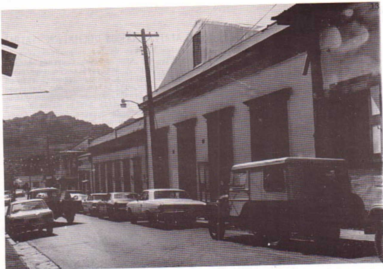
Antiguos almacenes de Sucesores de Fernando Pintueles y Cia., aún en existencia en la calle Muñoz Rivera de Ciales.
